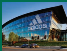
БЦ Крылатские холмы, ул. Крылатская
